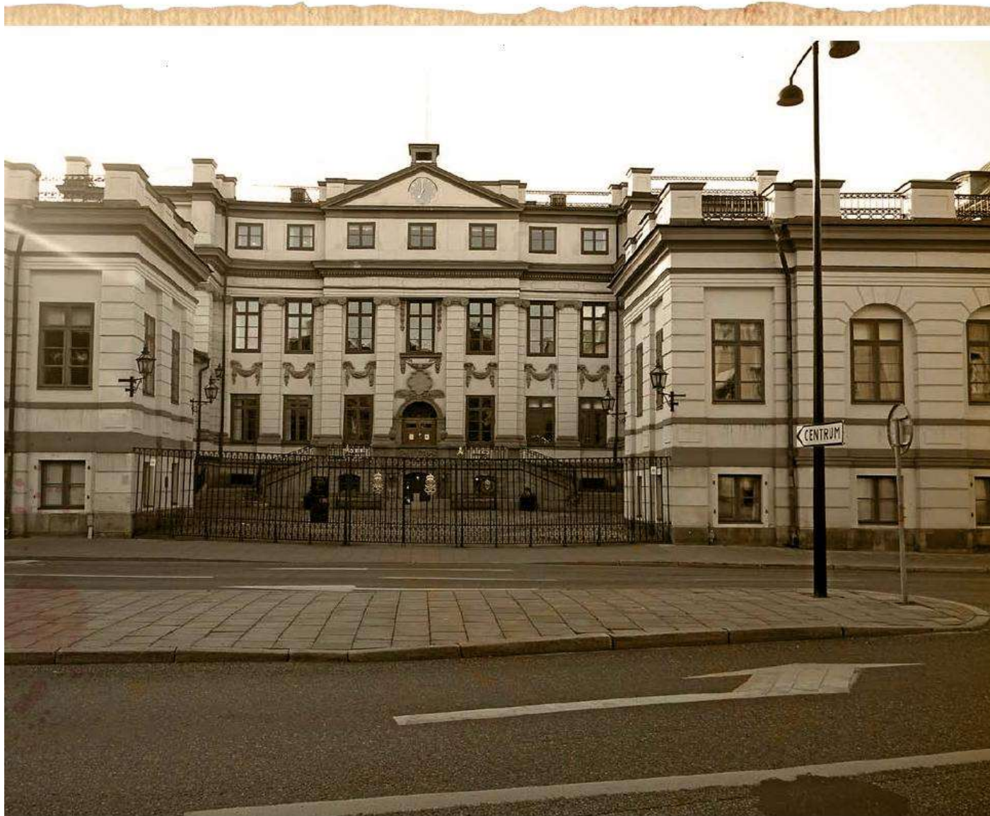
På gården innanför järngrindarna vid Bondeska palatset i Gamla stan dödades Axel von Fersen av rasande stockholmare. I dag finns Högsta domstolen i huset.
